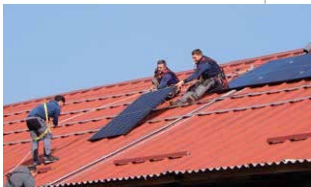
Cumiana 21 febbraio 2023. Tecnici all'opera per collocare i pannelli fotovoltaici del nuovo impianto. Nella seconda foto viene indicato dove sono stati collocati.
